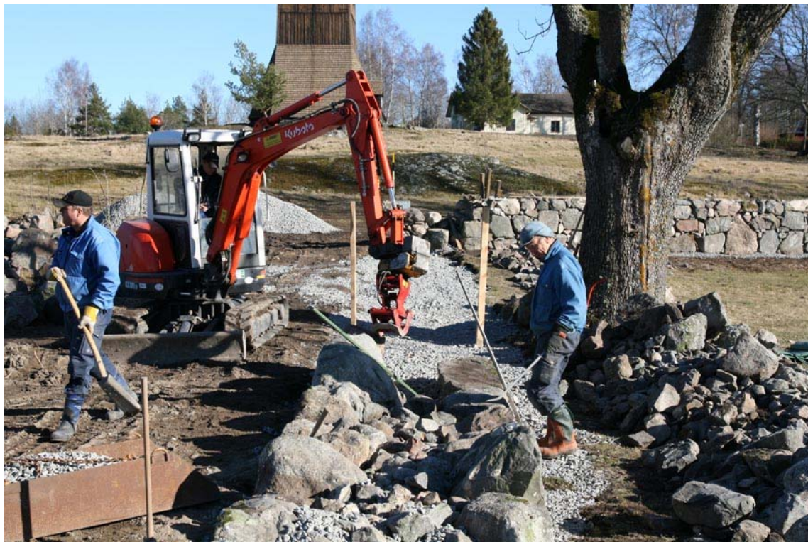
Stenarna läggs tillbaka på en bädd av makadam.
