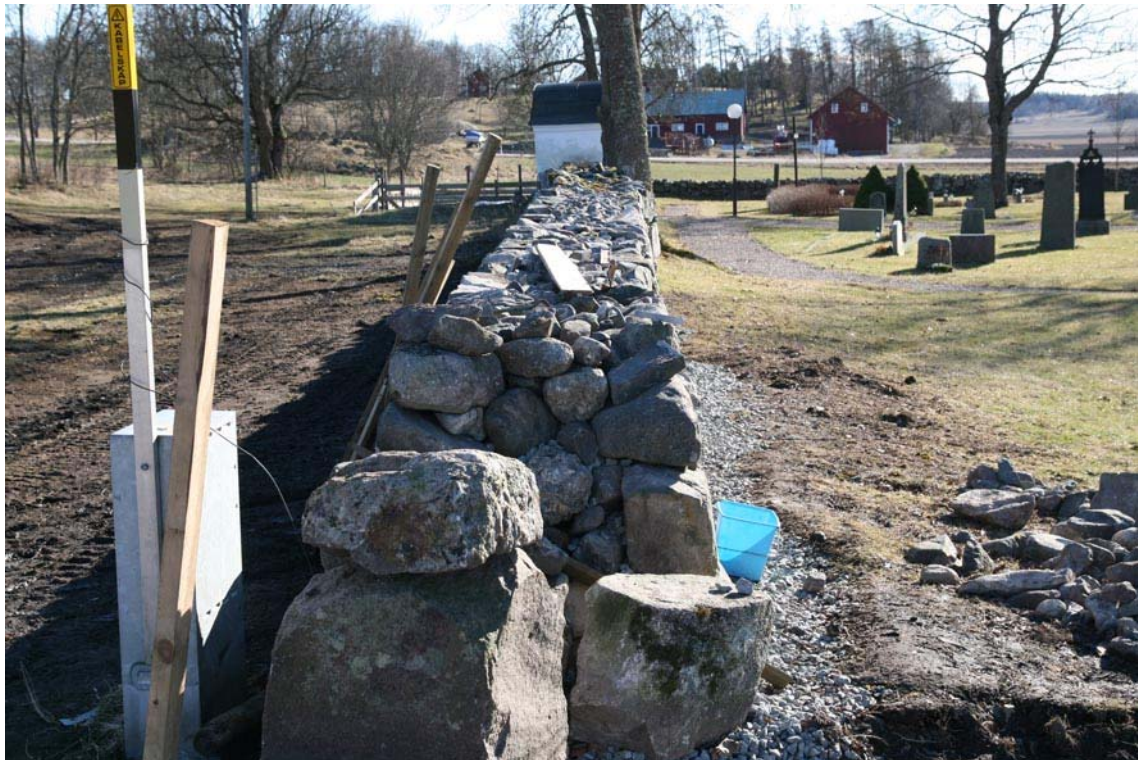
Snitt av östra muren, här ses skalmursupbyggnaden.
